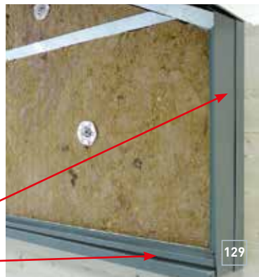
Ukośne łączenie z deską osłonową szczytową
