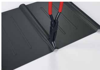
Rysunek 72 - Formowanie kalenicy za pomocą rąbka zaczepowego – dodatkowe wytyczne dla dachówki klasycznej
