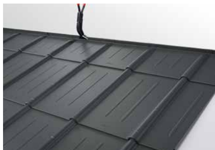
Rysunek 71 - Formowanie kalenicy za pomocą rąbka zaczepowego
